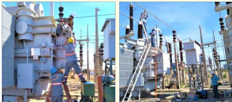
Manutenção Preventiva e corretiva nos transformadores das subestações EB-1 e EB- 2
