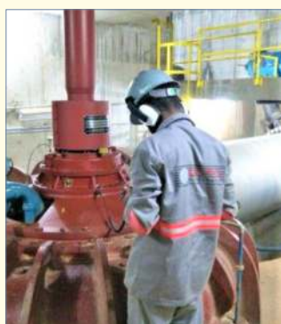
Análise de vibração e ruídos das bombas e Motores das Estações EB-1 e EB-2
