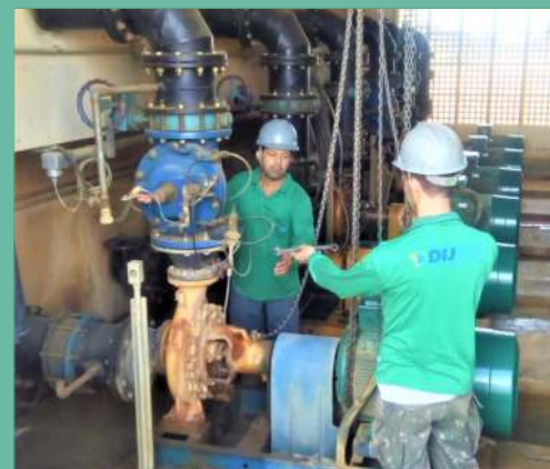
Manutenção no sistema hidromecânico e bombas das estações de pressurização coletiva da Área F
