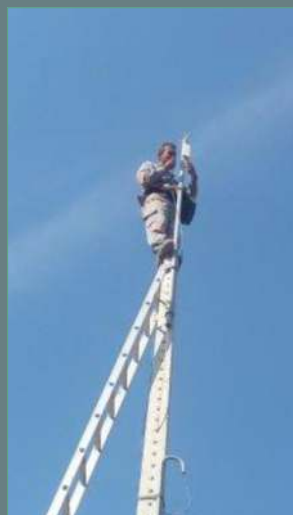
Revitalização da Torre do entroncamento principal do sistema de telecomunicação compreendendo os trabalhos de : modernização, instalação de novos rádios, novas antenas e novos cabos de rede
