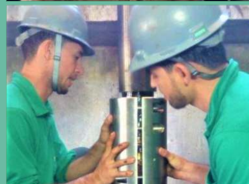
Manutenção preventiva e corretiva na bomba de vazão 3m³/s da Estação ER-C2
