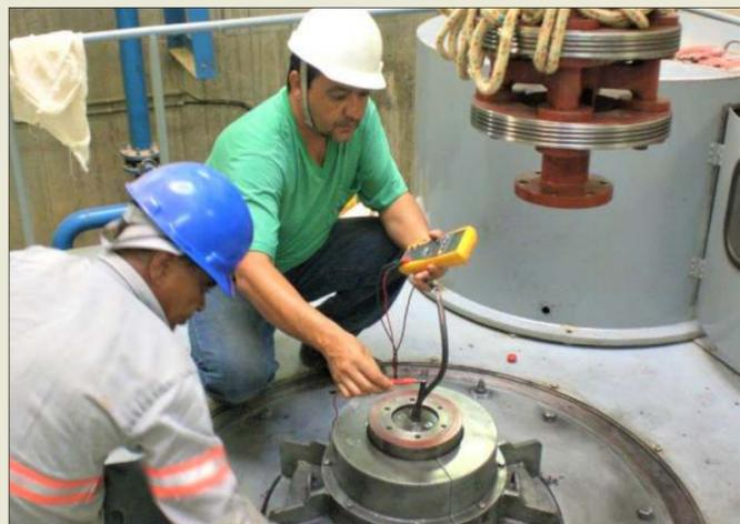
Manutenção do sistema coletor/escovas do rotor do motor da estação EB-1 e manutenção nos polos do disjuntor da subestação elétrica da estação EB-2
