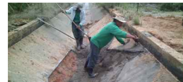
Mais de 5,4 mil metros de juntas dos canais de irrigação foram substituídas
