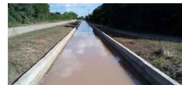
Nas margens dos canais de irrigação foram roçados mais de 210 mil metros de extensão
