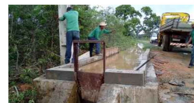
Em locais estratégicos, canais de irrigação receberam a construção de muretas
