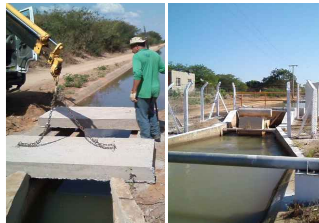
Construção de muretas e de passagem sobre os canais de irrigação
