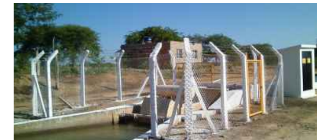
No ano passado as estações de bombeamento e comportas receberam serviços de pintura e manutenção
