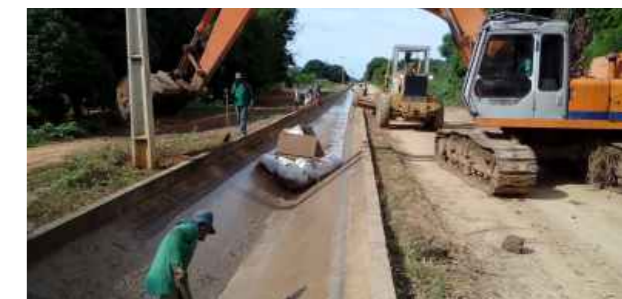
Em 2016 operários do DIJ desassorearam mais de 88 mil metros de canais de irrigação
