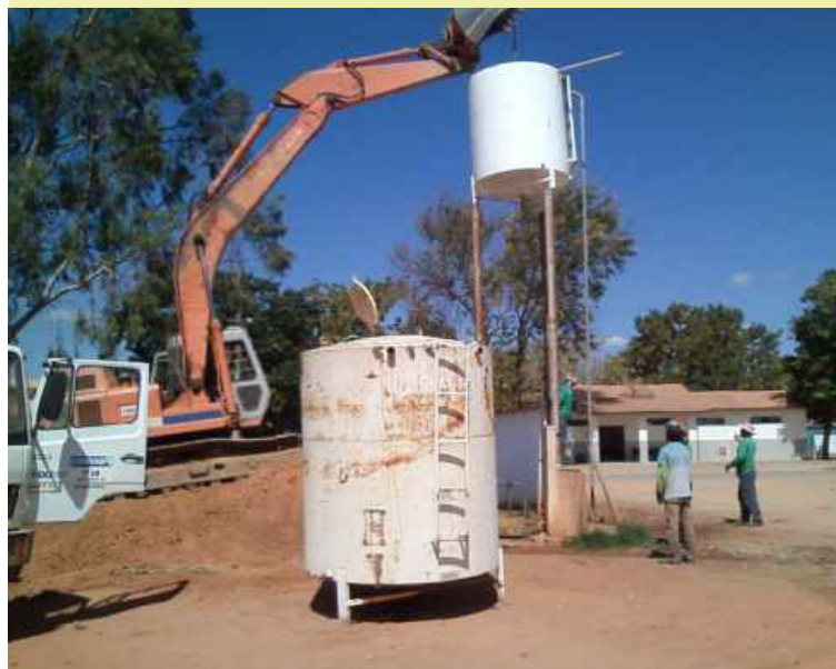
Nas comunidades NH1 e NH2 o DIJ substituiu dois reservatórios de água que atende demanda dos moradores. O trabalho terá continuidade neste ano
